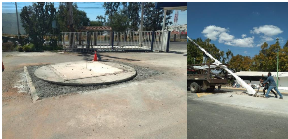
Ilustración 14. Instalación de asta bandera.
