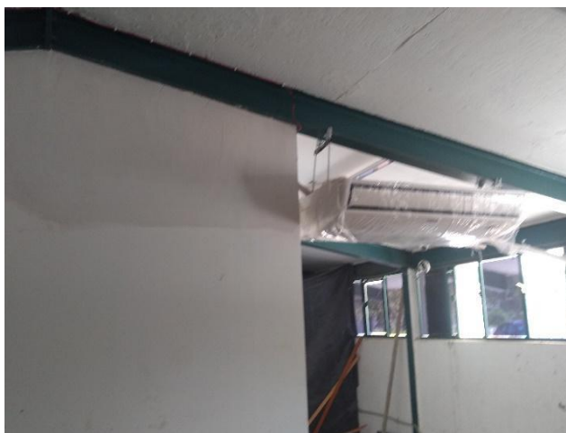
Ilustración 10. Reubicación de aire acondicionado
