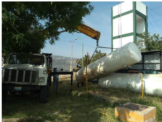
Ilustración 13. Reubicación de tanques de gas.
