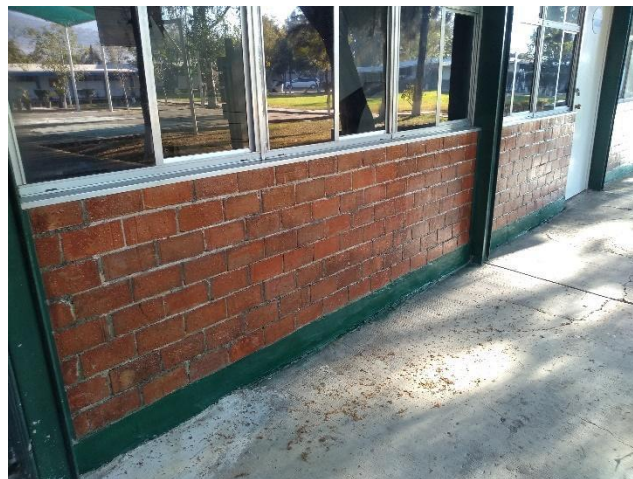
Ilustración 15. Mantenimiento a muros de ladrillo.
