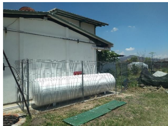
Ilustración 13. Reubicación de tanques de gas.
