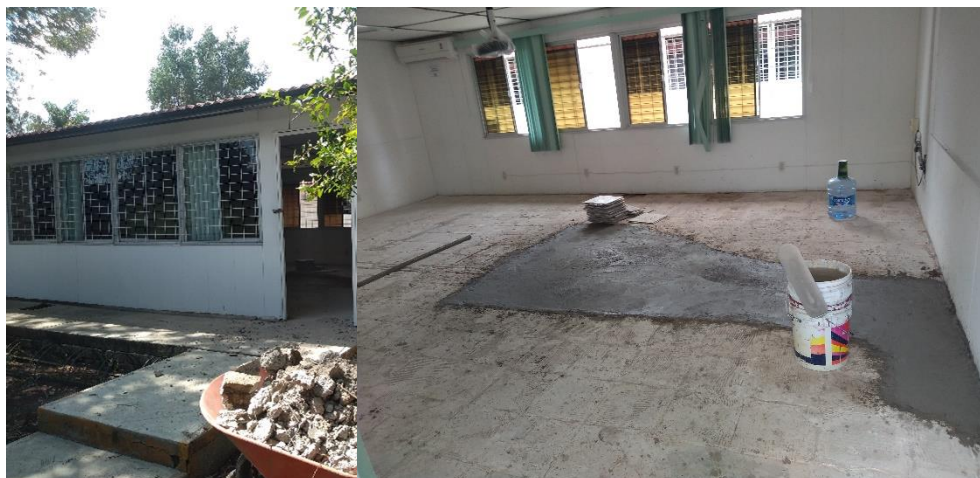
Ilustración 18. Adquisición de productos de concreto para ser utilizados en la reparación de aulas móviles del instituto.
