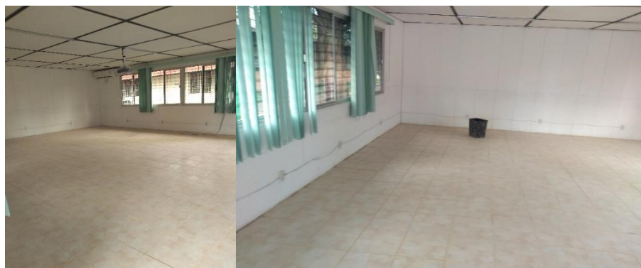
Ilustración 17. Mantenimiento correctivo al piso de las aulas número 15, 16, 17 y 18.
